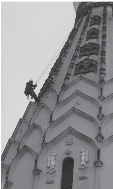
Obr. 7: Výškové práce s využitím lan
