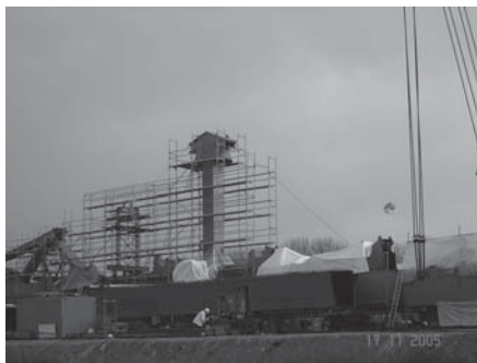
Obr. 4: Pracovní a zabezpečovací konstrukce
