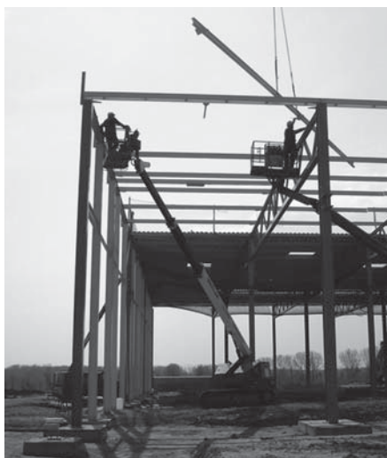
Obr. 5: Pracovní podlahy ve výšce
