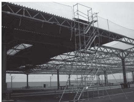
Obr. 13: Volně stojící schodišťová věž
