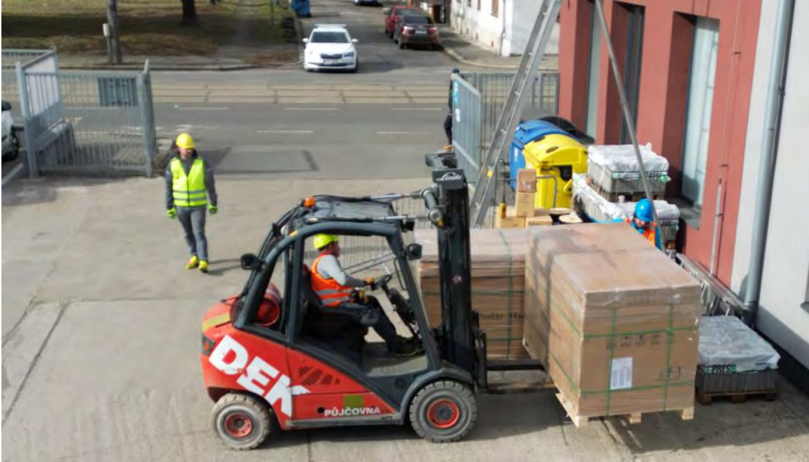
Zabezpečení prostoru stavby při manipulaci s materiálem
