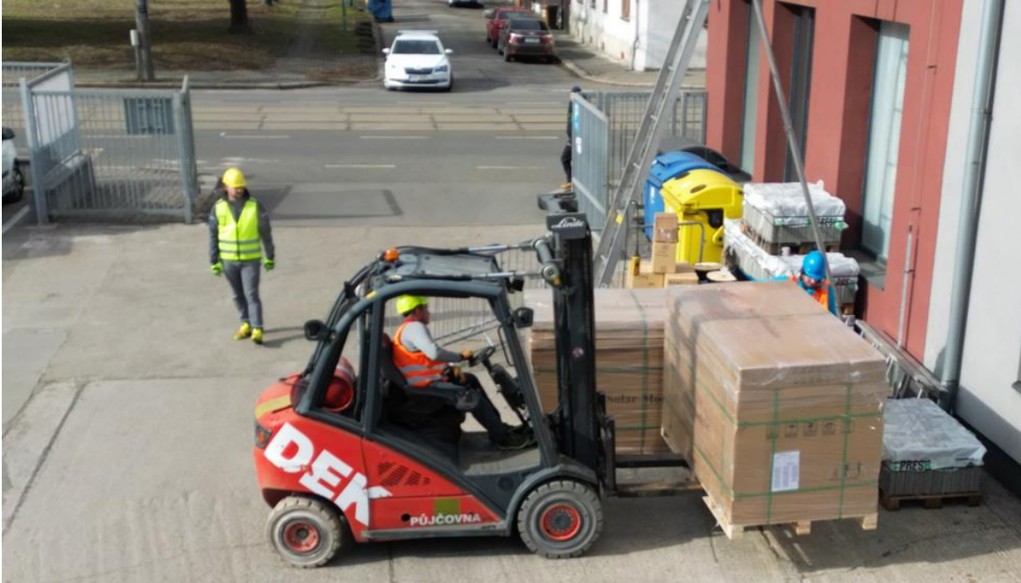
Zabezpečení prostoru stavby při manipulaci s materiálem
