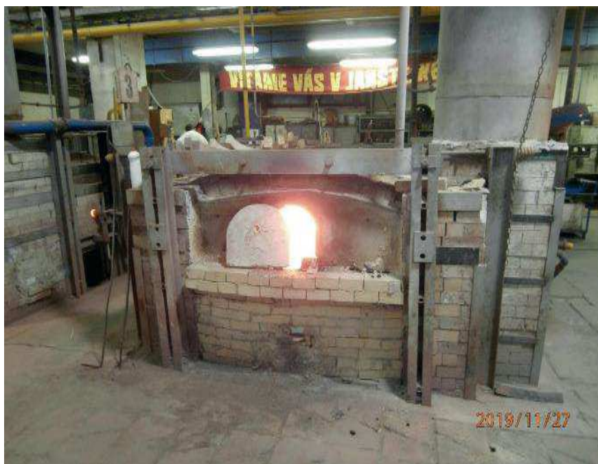
Obr. 2B Měření 1,5 m od otvoru pánvové pece
